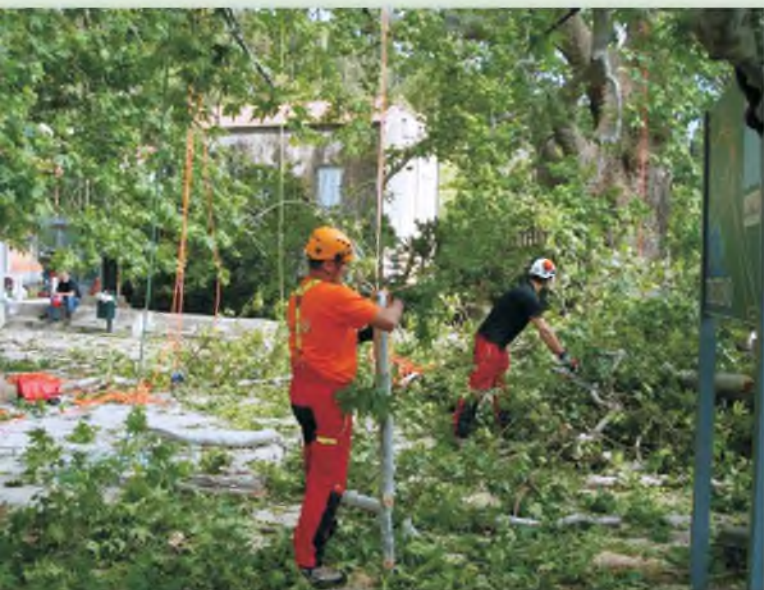
Slika 4. Radovi na sanaciji
